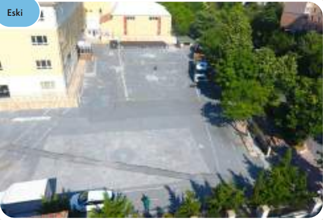
*BÜYÜKŞEHİR MAH. BÜYÜKŞEHİR İLKOKULU BAHÇE ASFALT KAPLAMA VE ÇİZGİ ÇALIŞMASI - FEN İŞLERİ MD.
