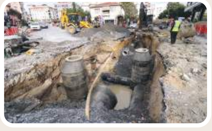
* KAVAKLI MAH. MARMARA CD YAĞMURSUYU VE ATIK SU KANAL ÇALIŞMASI FEN İŞLERİ MD.- İ.B.B. İŞBİRLİĞİ
