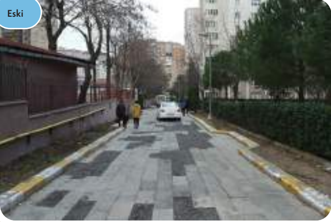
*BÜYÜKŞEHİR MAH. SEVEN SK ASFALT KAPLAMA - FEN İŞLERİ MD.- İ.B.B. İŞBİRLİĞİ
