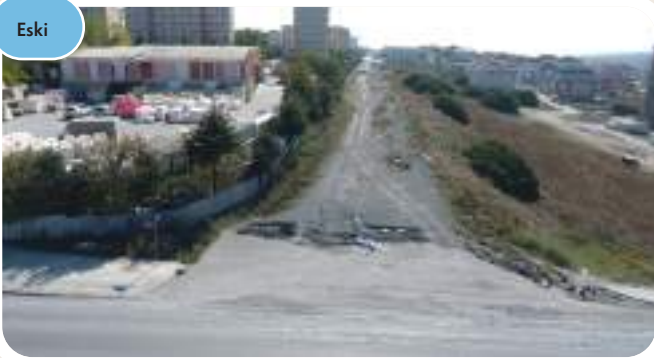
* KAVAKLI MAH. GENÇLİK CD YENİ YOL AÇILMA VE ASFALT KAPLAMA - FEN İŞLERİ MD.- İ.B.B. İŞBİRLİĞİ
