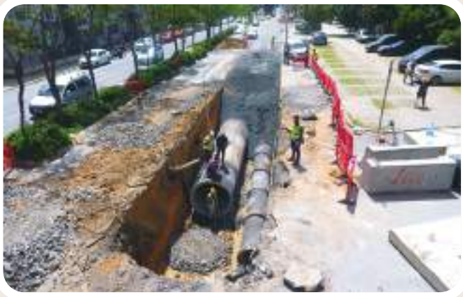
*BARIŞ MAH. ENVER ADAKAN CD YAĞMURSUYU VE ATIK SU KANAL ÇALIŞMASI FEN İŞLERİ MD.- İ.B.B. İŞBİRLİĞİ
