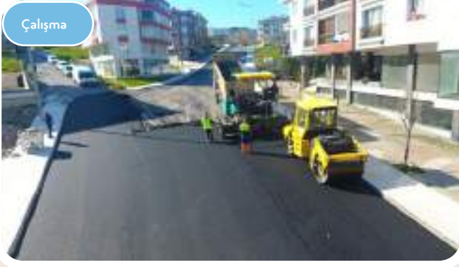
*KAVAKLI MAH. ESKİPINAR CD ASFALT KAPLAMA - FEN İŞLERİ MD.- İ.B.B. İŞBİRLİĞİ
