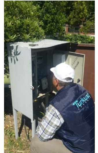
BÜYÜKŞEHİR MAHALLESİ ATRIUM PARKI AYDINLATMA SİSTEMLERİNİN TAMİR VE BAKIMI
