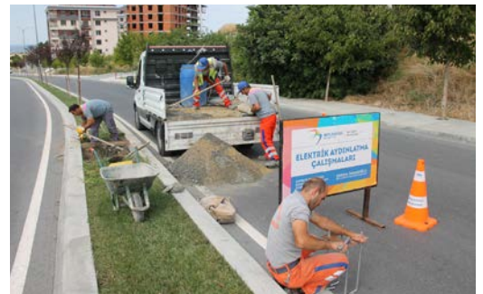
ELEKTRİK AYDINLATMA ÇALIŞMALARI
