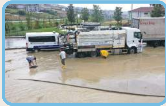
*VOLVO KAVŞAĞI TIKANAN IZGARALARIN AÇILMASI ÇALIŞMASI - FEN İŞLERİ MD.
