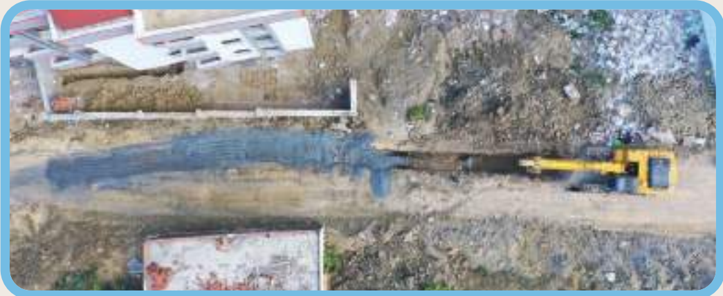
*SAHİL MAH. ŞENTÜRK SOK. YAĞMURSUYU KANAL ÇALIŞMASI - FEN İŞLERİ MD.
