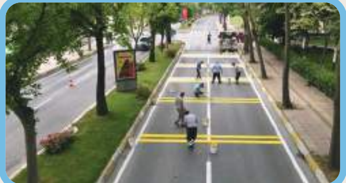
*CUMHURİYET MAH. CUMHURİYET CAD. HIZ KESİCİ BANT UYGULAMASI - FEN İŞLERİ MD.
