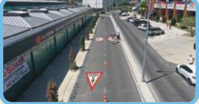
*ADNAN KAHVECİ MAH. ERDEMLİ CAD. PREMARK UYGULAMA ÇALIŞMASI - FEN İŞLERİ MD.
