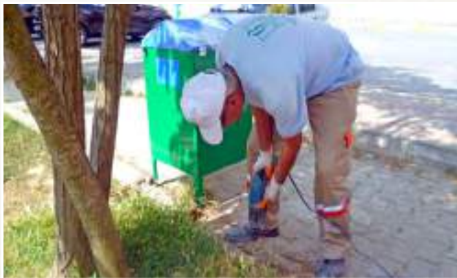
Ekmek Kumbaralarının Montajının Yapımı (46 adet)
