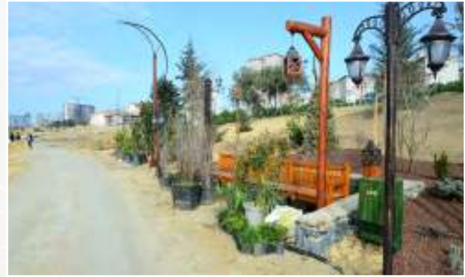
Bank ve Çöp kovası (2.228 adet) Montajı
