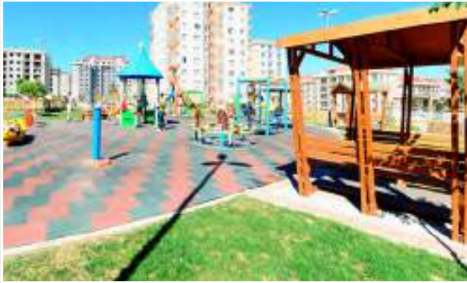
Kamelya (8 adet) ve Pergole (4 adet) Montajı
