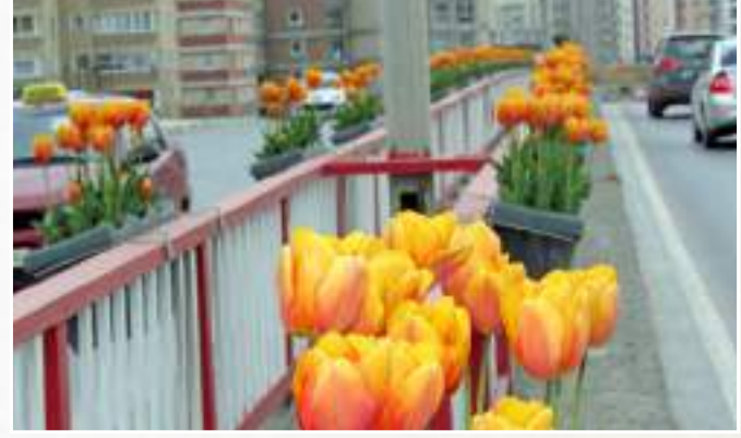
İlçeye Modüler Saksı (410 adet) (2 adet) Montajının Yapılması
