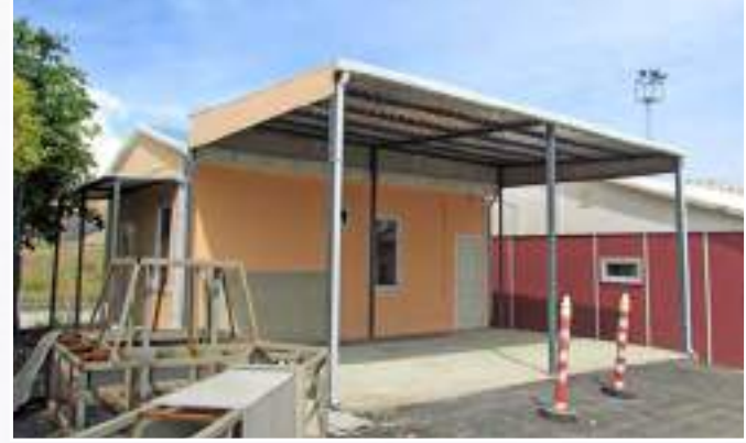
2013 yılı içerisinde 1 adet 40m 2 prefabrik yapı yapılmıştır.
