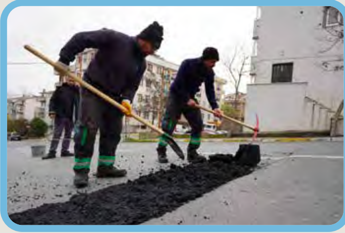
* SOĞUK ASFALT YAMA ÇALIŞMASI YAPILMASI - FEN İŞLERİ MD.
