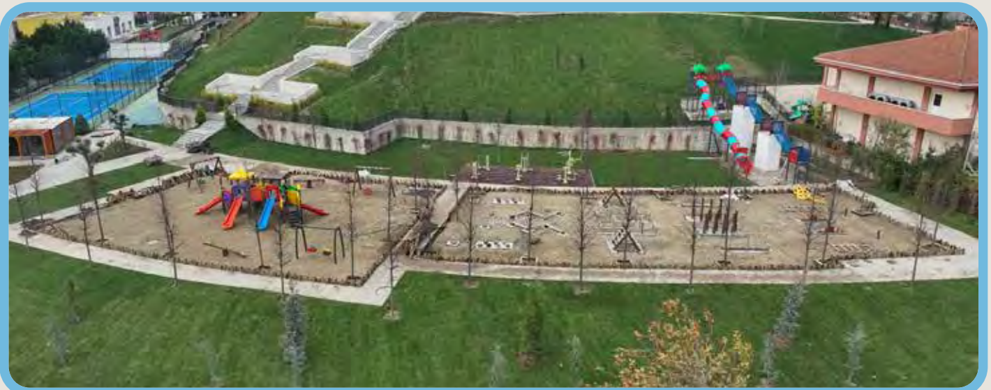
*GÜRPINAR KENT ORMANI DIŞ MEKAN OYUN GRUPLARININ MONTAJLARININ YAPILMASI - PARK VE BAĞÇELER MD.
