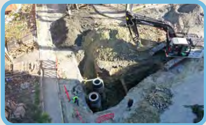
* YAKUPLU MAH. 44 SOK. YAĞMUR SUYU KANAL ÇALIŞMASI- FEN İŞLERİ MD.
