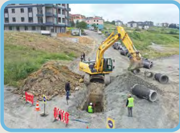
* KAVAKLI MAH. BAĞLAR CAD. YAĞMUR SUYU KANAL ÇALIŞMASI- FEN İŞLERİ MD.
