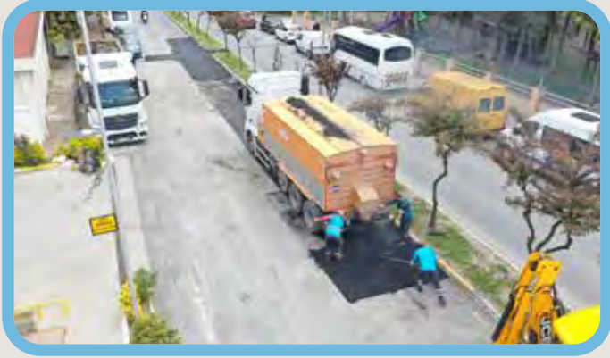
* ADNAN KAHVECİ ÇAMBAŞI CAD. ASFALT YAMA ÇALIŞMASI YAPILMASI - FEN İŞLERİ MD.
