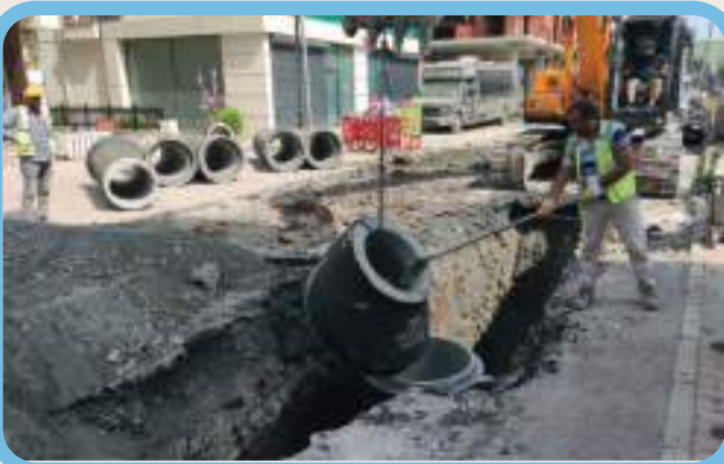
* KAVAKLI MH KÖPRÜLÜ MEHMET PAŞA SK YAĞMUR SUYU KANAL ÇALIŞMASI FEN İŞLERİ MD.
