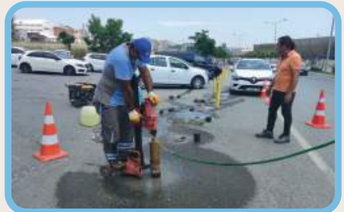
* YAKUPLU MH HÜRRIYET BULVARI KAYMAKAMLIK ÖNÜ DEMİR DUBA YAPIMI FEN İŞLERİ MD.
