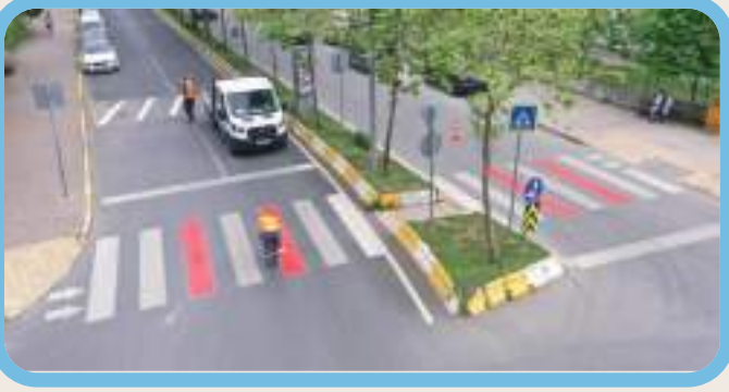
* A.KAHVECİ MH OSMANLI CD ÖNCE YAYA GEÇİDİ UYGULAMASI FEN İŞLERİ MD.
