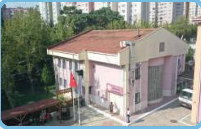
* BÜYÜKŞEHİR MH KAVAKLI ANAOKULU DIŞ CEPHE BOYAMA ÇALIŞMASI - FEN İŞLERİ MD.
