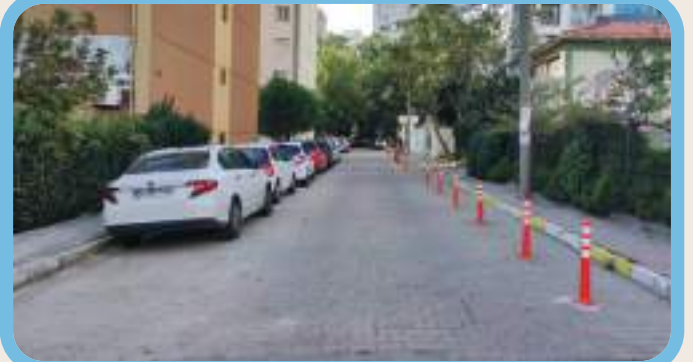
* BARIŞ MH BURSA ÇIKMAZI SK PLASTİK DELİNATÖR UYGULAMASI FEN İŞLERİ MD.
