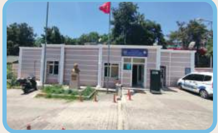
* ŞEHİT ORHAN ŞAHİN POLİS MERKEZİ DIŞ CEPHE BOYA ÇALIŞMASI - FEN İŞLERİ MD.
