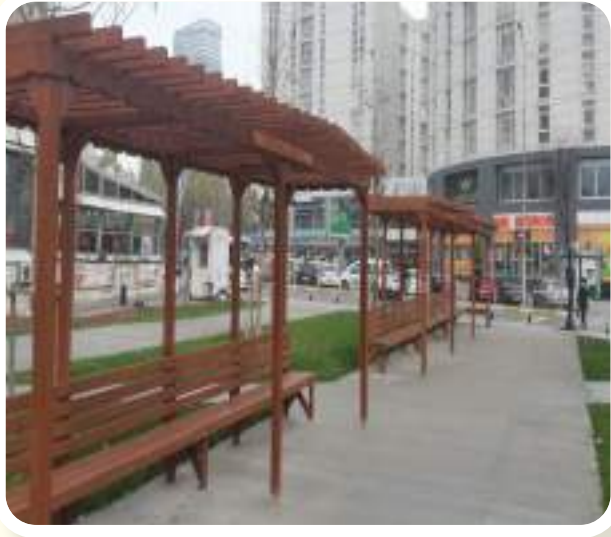
• GÖLGELEME ELEMANLARI MONTAJI - PARK VE BAHÇELER MÜD.
