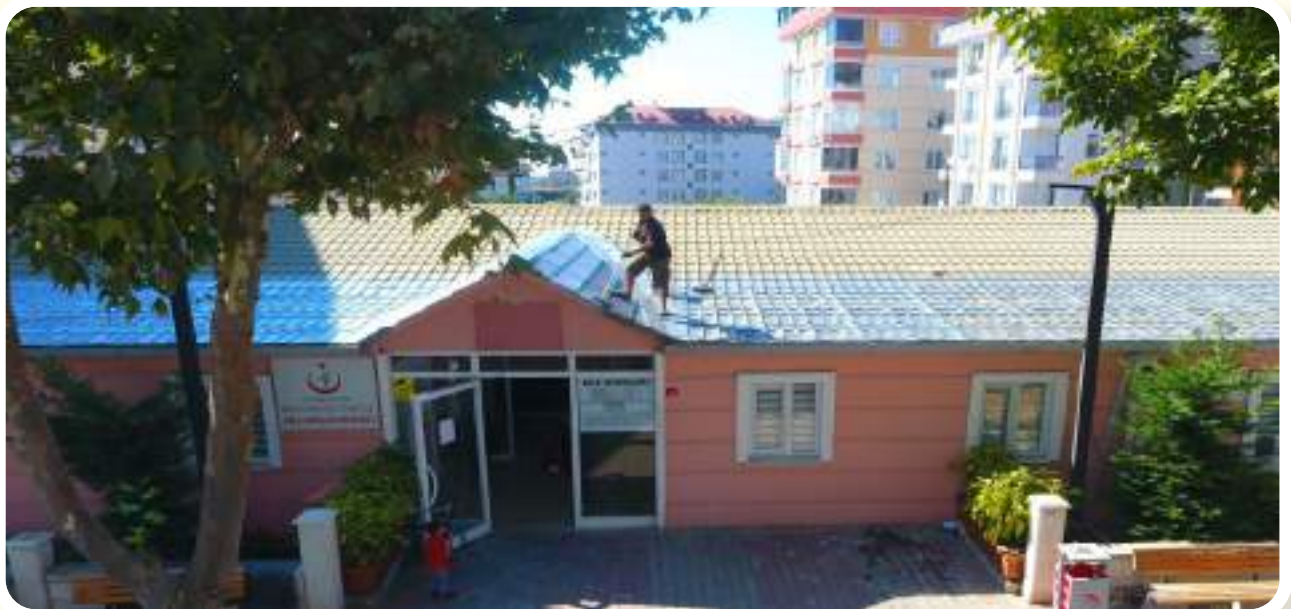
• DEREĞZİ MH 5 NOLU SAĞLIKOCAĞI ÇATI İZALASYONU YAPILMASI - FEN İŞLERİ MÜD.
