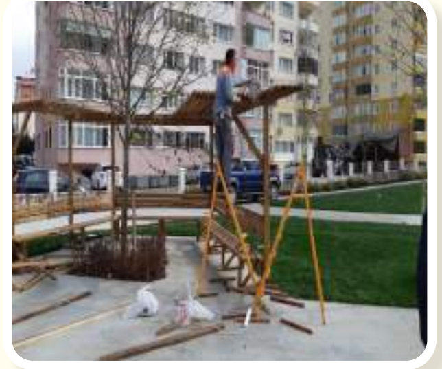
• GÖLGELEME ELEMANLARI MONTAJI - PARK VE BAHÇELER MÜD.
