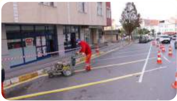
• KAVAKLI MAHALLESİ İSTANBUL CADDESİ OTOYOLU ÇİZGİ UYGULAMASI FEN İŞLERİ MÜD.
