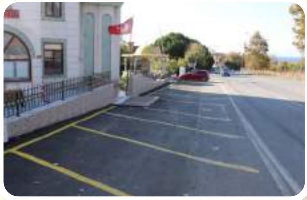
• DEREĞİZİ MAHALLESİ ZEYNEP HATUN CAMİİ ÖNÜ OTOYOLU ÇALIŞMASI FEN İŞLERİ MÜD.
