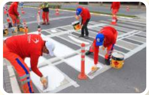
KAVAKLI MAHALLESİ AYASOFYA CADDESİ YAYA GEÇİDİ BOYAMA ÇALIŞMASI - FEN İŞLERİ MÜD.
