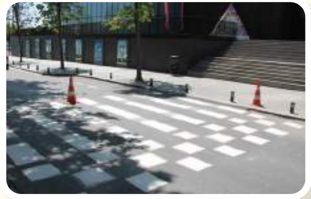
• CUMHURİYET MAHALLESİ CUMHURİYET CADDESİ HIZ KESİCİ KASIS BOYAMA ÇALIŞMASI - FEN İŞLERİ MÜD.
