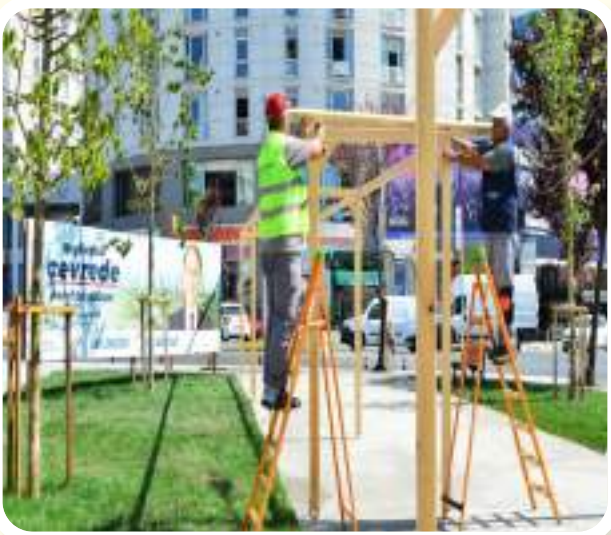
• GÖLGELEME ELEMANLARI MONTAJI - PARK VE BAHÇELER MÜD.
