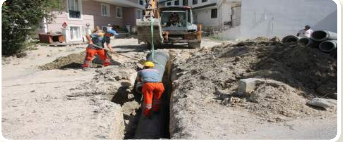
• GÜRPINAR MAHALLESİ DEMİRCİ SOKAK YAĞMUR SUYU KANAL ÇALIŞMASI - FEN İŞLERİ MÜD.
