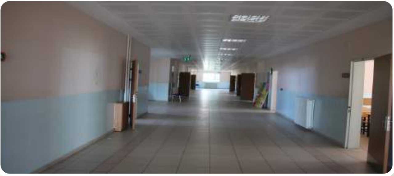
• KAVAKLI MAHALLESİ GÜRPINAR ORTAOKULU İÇ CEPHE BOYA YAPILMASI - FEN İŞLERİ MÜD.
