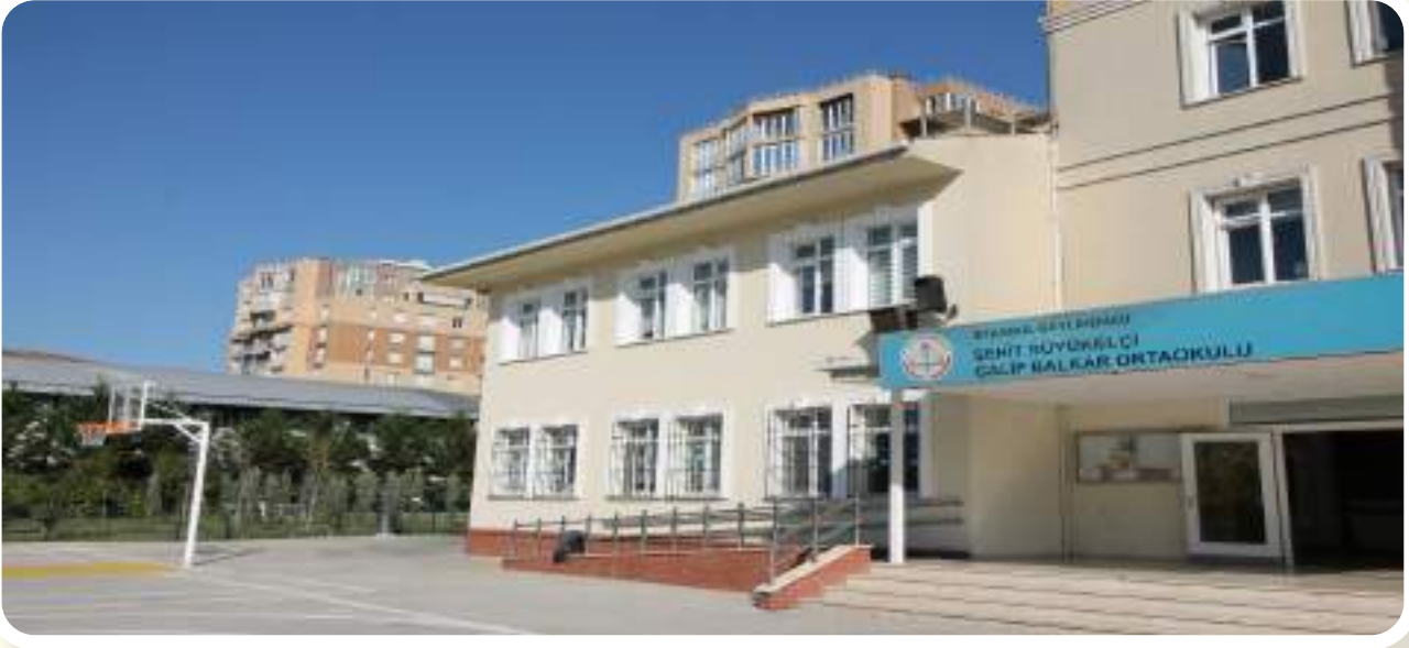
• KAVAKLI MAHALLESİ ŞEHİT BÜYÜKELÇİ GALİP BALKAR ORTAOKULU DIŞ CEPHE BOYA YAPILMASI - FEN İŞLERİ MÜD.
