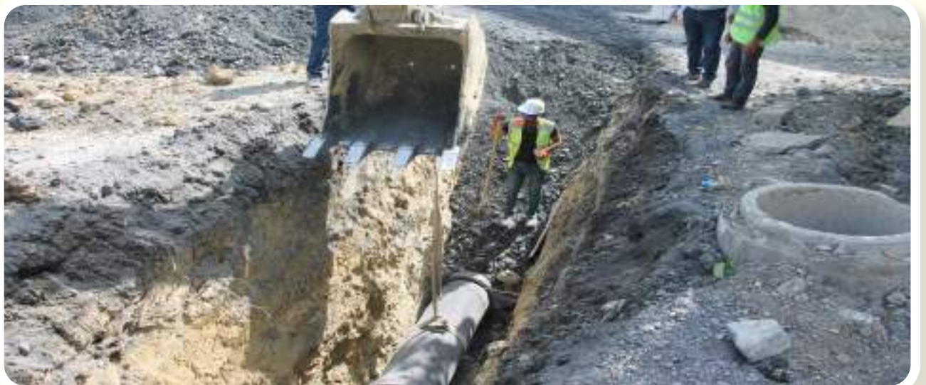
• KAVAKLI MAHALLESİ MARTI SOKAK YAĞMUR SUYU KANAL ÇALIŞMASI - FEN İŞLERİ MÜD.
