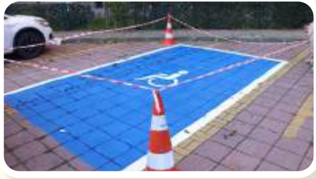
• BÜYÜKŞEHİR MAHALLESİ BAŞAK SOKAK ŞABLON UYGULAMASI FEN İŞLERİ MÜD.
