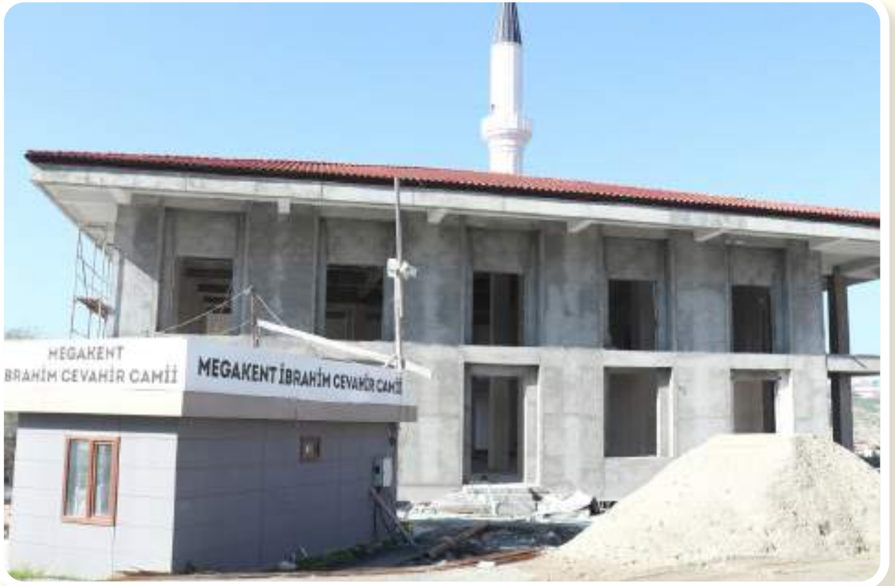
• BARIŞ MAH. MEGAKENT İBRAHİM CEVAHİR CAMİİ YAPIMI - FEN İŞLERİ MÜD.
