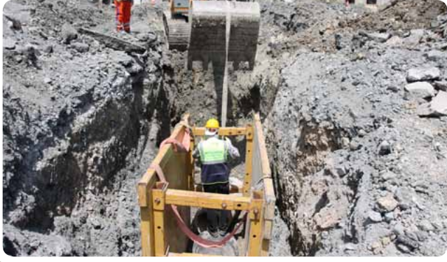
ADNAN KAHVECİ MAHALLESİ ERMAN SOKAK YAĞMURSUYU KANAL ÇALIŞMASI • FEN İŞLERİ MD.
