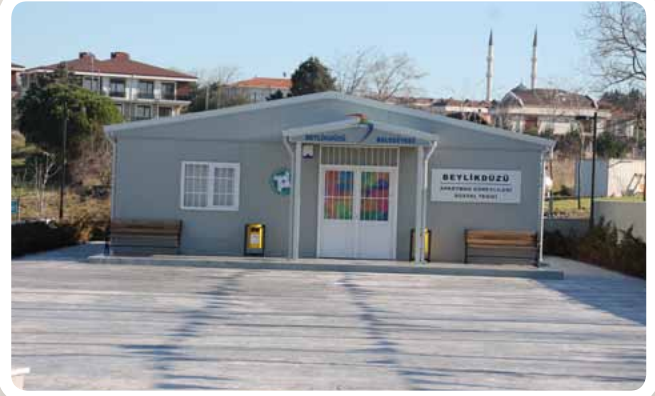
▼ DEREAĞZI MAHALLESİ APARTMAN GÖREVLİLER LOKALI • FEN İŞLERİ MD.
