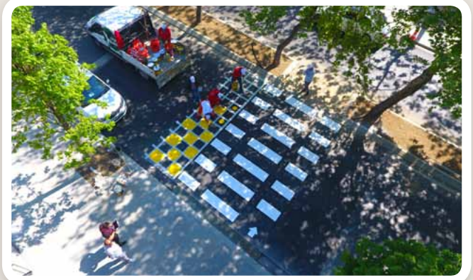
▼ CUMHURİYET MAHALLESİ CUMHURİYET CADDESİ YAYA GEÇİDİ VE YOL ÇİZGİ BOYAMA ÇALIŞMASI • FEN İŞLERİ MD.
