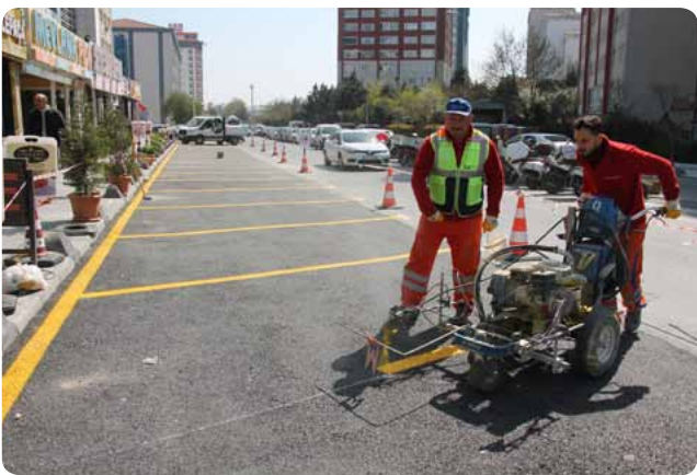
▼ BARIŞ MAHALLESİ ALİ ÇEBİ CADDESİ OTOYOL BOYAMA ÇALIŞMASI • FEN İŞLERİ MD.
