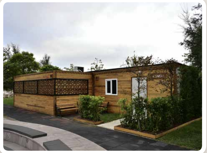
▼ PREFABRİK YAPI ALANI YAPIMI (70 M 2 ) • PARK VE BAĞÇELER MD.
