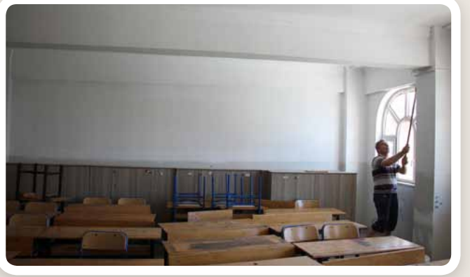
BARIŞ MAHALLESİ İMKB LİSESİ BOYAMA ÇALIŞMASI • FEN İŞLERİ MD.
