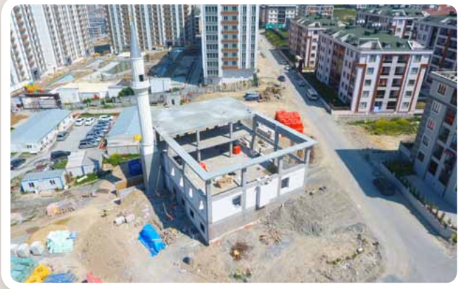
▼ KAVAKLI MAHALLESİ HUZURLU CAMİİ YAPIMI • FEN İŞLERİ MD.
