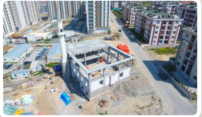
▼ KAVAKLI MAHALLESİ HUZURLU CAMİİ YAPIMI • FEN İŞLERİ MD.
