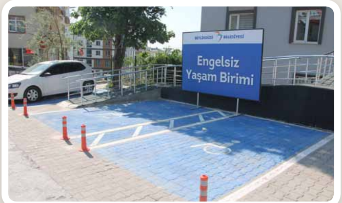
▼ KAVAKLI REHABİLİTASYON MERKEZİ ENGELLİ OTOPARK YAPIMI • FEN İŞLERİ MD.
