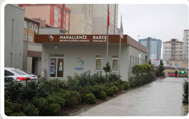
BARİŞ MAHALLESİ MUHTARLIK YAPIMI VE ÇEVRE DÜZENLEMESİ • FEN İŞLERİ MD. / PARK VE BAĞÇELER MD.
