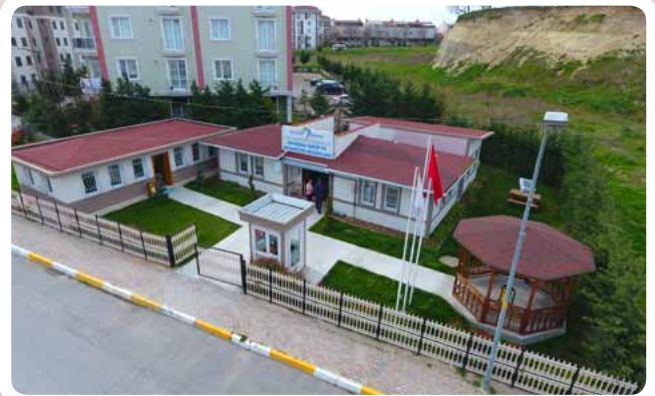
▼ GÜRPINAR MAHALLESİ REHABİLİTASYON MERKEZİ EK BİNA YAPIMI VE ÇEVRE DÜZENLEMESİ • FEN İŞLERİ MD. / PARK VE BAHÇELER MD.
