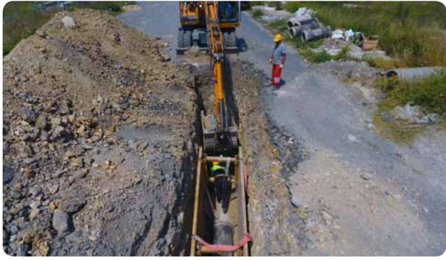
ADNAN KAHVECİ MAHALLESİ GÖLBOYU CADDESİ YAĞMURSUYU KANAL ÇALIŞMASI • FEN İŞLERİ MD.
